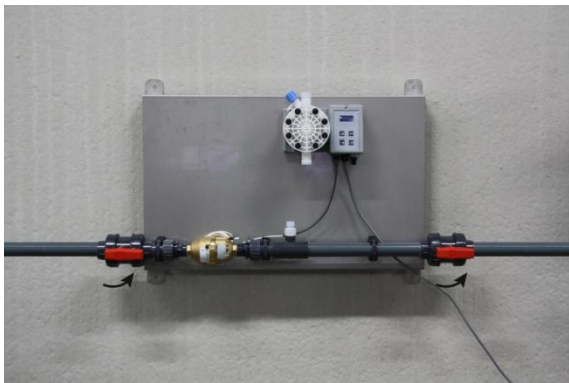
Abbildung 1: Kugelventile öffnen
