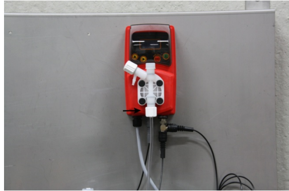
Abbildung 6: Saugschlauch anschließen
