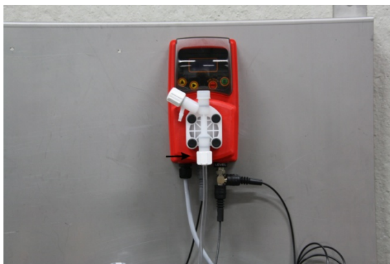
Abbildung 3: Saugschlauch anschließen
